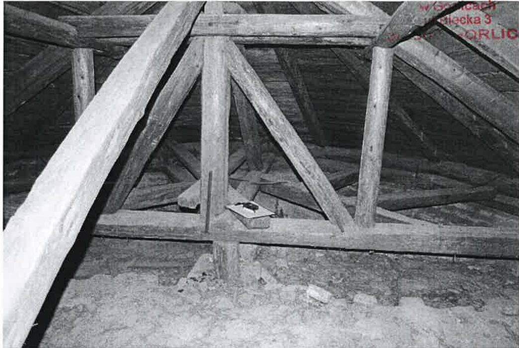
fot. 9. Konstrukcja więźby dachowej.
