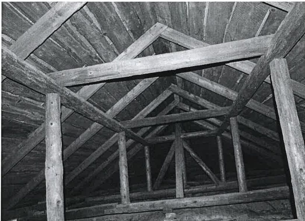
fot. 8. Konstrukcja więźby dachowej.
