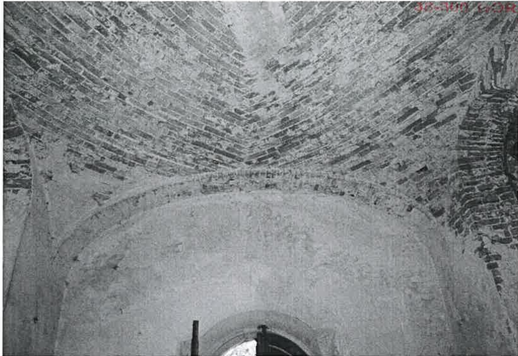
fot. 9. Sklepienie ceglane nad nawą .
