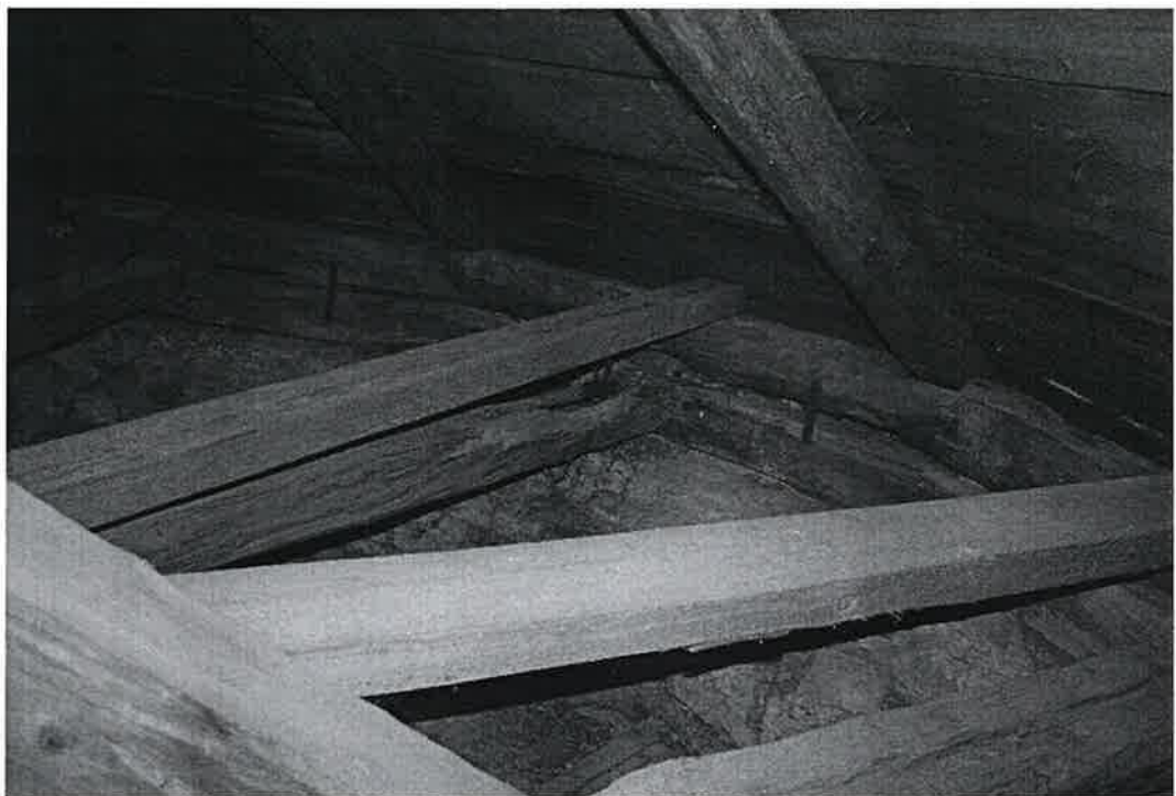
fot. 10. Konstrukcja więźby dachowej. Widoczne zniszczone elementy (dołożone elementy wzmacniające)
